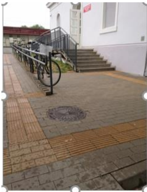
Zdjęcie 10 obrazuje ścieżkę naprowadzającą do budynku.
